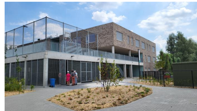
Foto 2 Sportkooi, fietsenstalling en overdekte speelplaats
